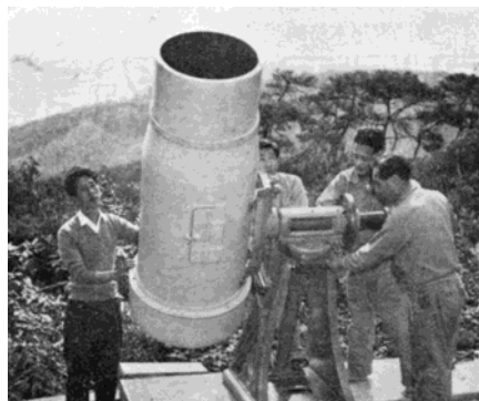
人工衛星観測用に開発された花山 天文台のシュミットカメラ (1957)
