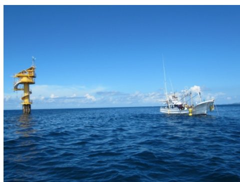
写真 5：観測塔と作業船
