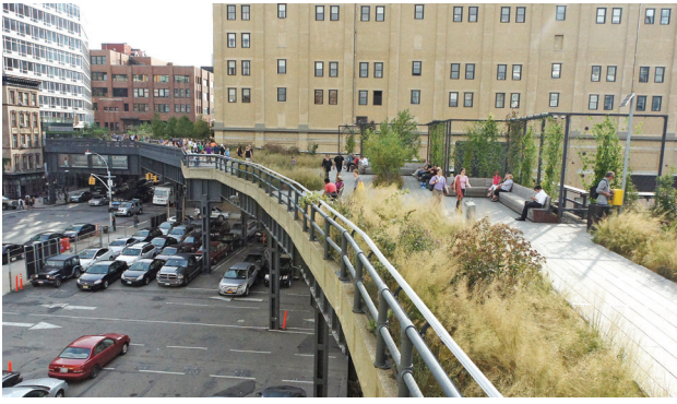
写真-1 再利用率後のハイラインの様子
