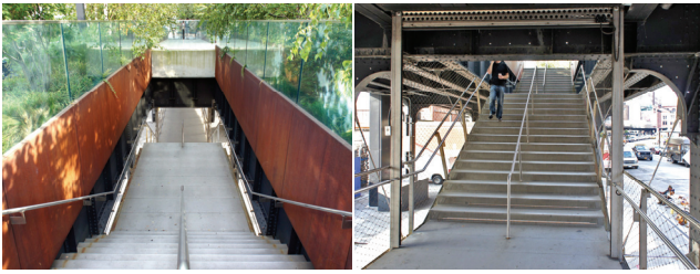
写真-2 ハイラインへの導入部における床版の切断
