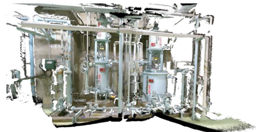
図 1 プラントの環境再構成モデルの例 Fig.1 An example of dismantling field's reconstruction model.
