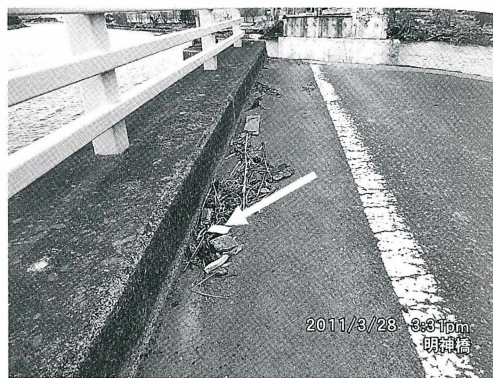
写真7 橋の先端部に残る木切れ・漂着物痕跡
