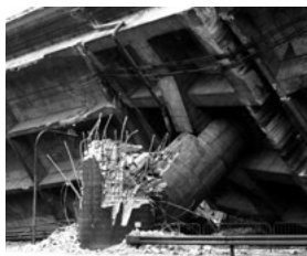
高速道路のビルト橋の倒壊
