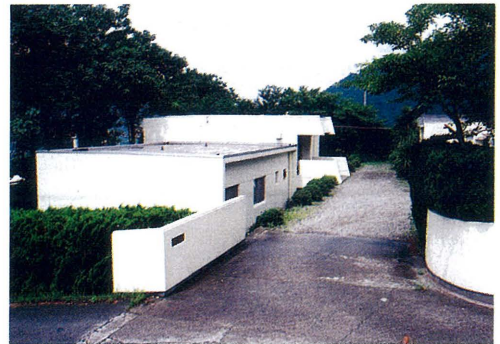
写真-2・16 徳島地すべり観測所本館
