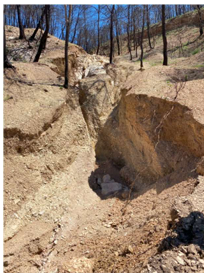
図-2 火災後の斜面崩壊
