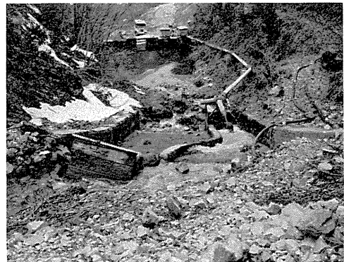
写真-2・27 ヒル谷流砂観測装置
