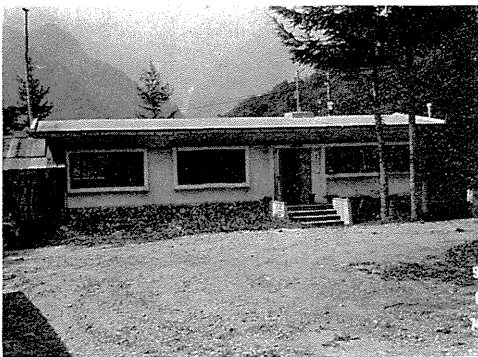
写真-2・26 穂高砂防観測所
