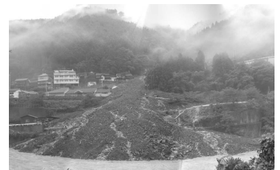
紀伊半島大水害 発災直後の写真 (奈良県大塔村)
