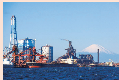
海から見た君津製鐵所の設備群
