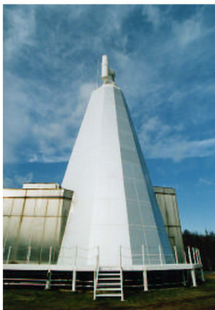
新装なった塔体冷却パネル
