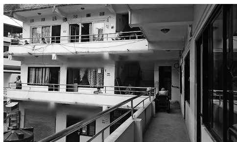
写真1 介護施設の建物
