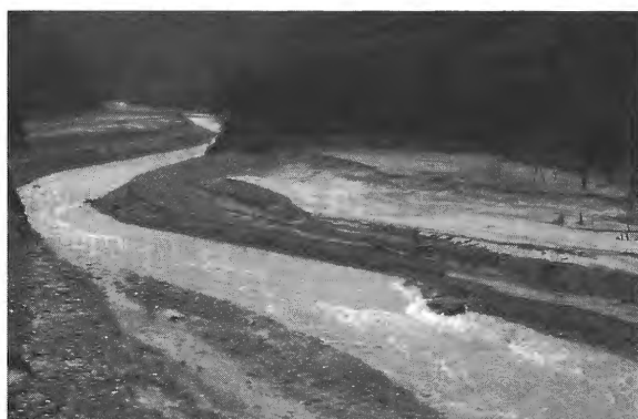
写真—4 黒部川出し平ダムの貯水池内に形成された水みち（フラッシング排砂水路）
