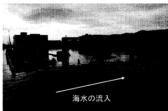
図—7 石巻漁港東端部の海水流入の状況
