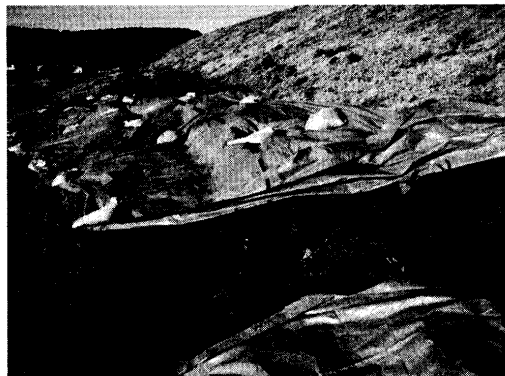
図一17 北上川中流部右岸(45.5 k)付近の小段に発生した円弧上の亀裂
