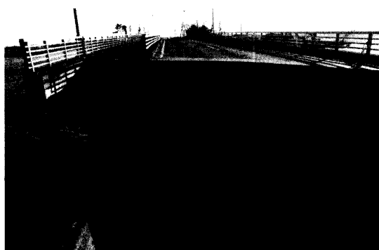
図一15 定川大橋右岸、取付け盛土の流失状況
