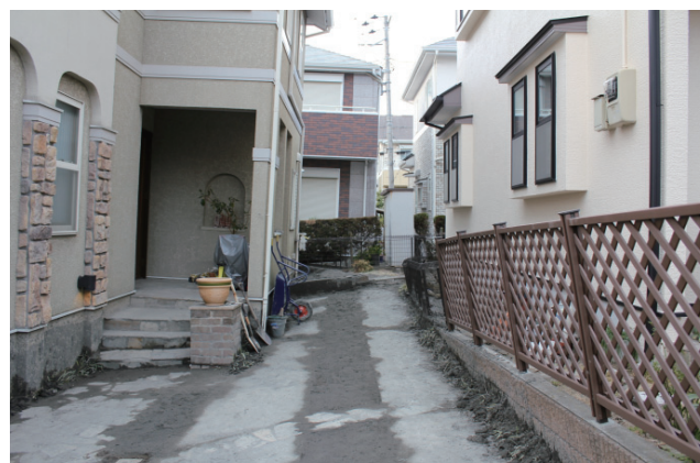
写真5 傾斜した住宅
