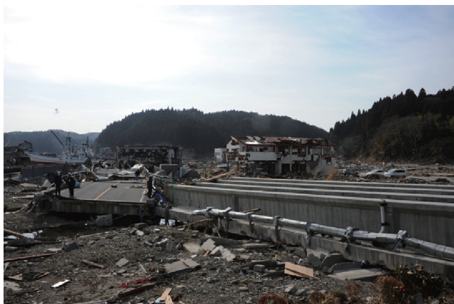
写真5 歌津地区のコンクリート橋の流出
