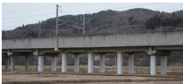
写真1 鋼板巻立て補強された新幹線高架橋
