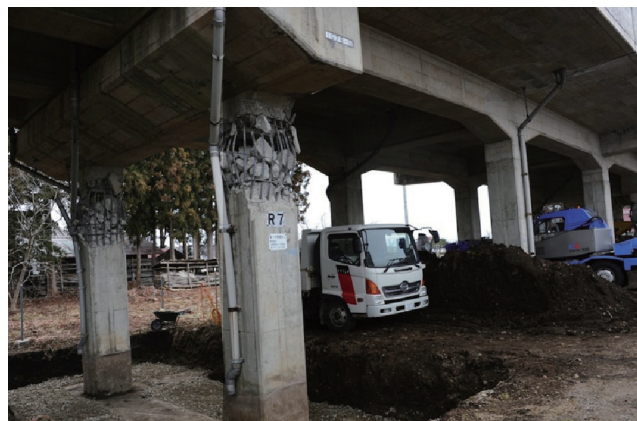
写真2 軸力支持能力を喪失するほど破壊された柱
