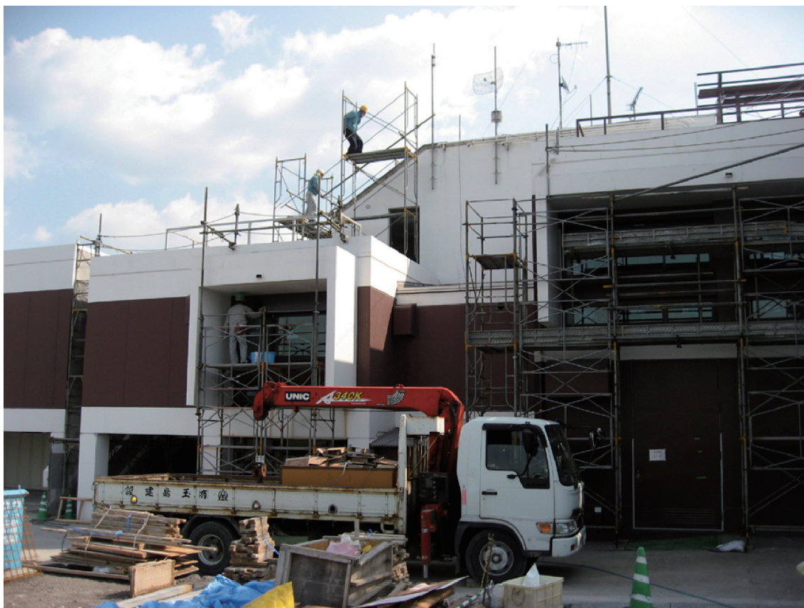
耐震改修工事中
