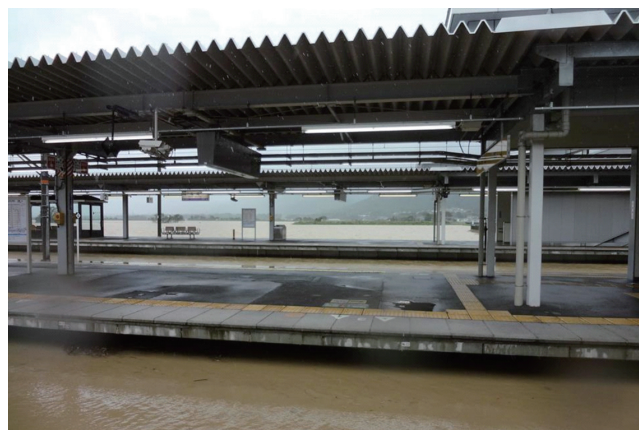
写真2 浸水した JR 亀岡駅（9月16日、堀教授撮影）
