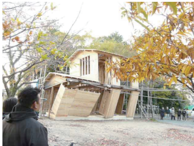
写真2 補強試験体の倒壊直前の状況
