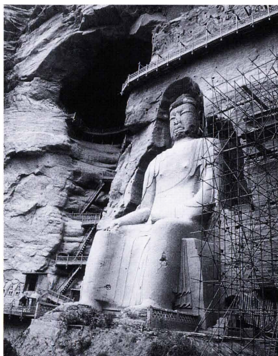
図1 栴檀寺石窟。ダムの影響で水位が上がり、劣化してきたため、保存修復工事を行っている
