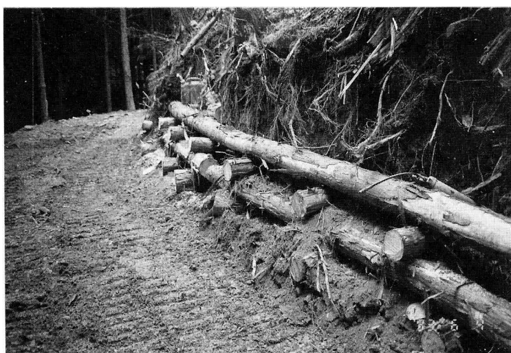
写真-3 完成した法面
