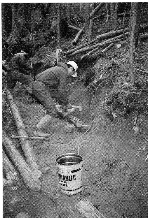
写真-2 丸太積作業
