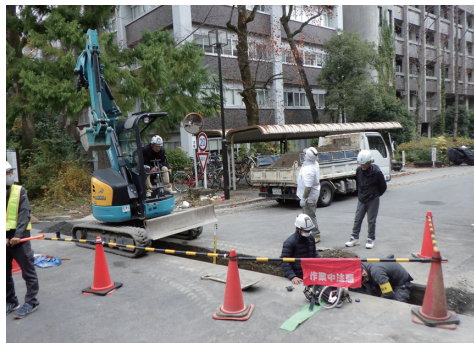
1. 調査地西半掘削状況 (東南から)
