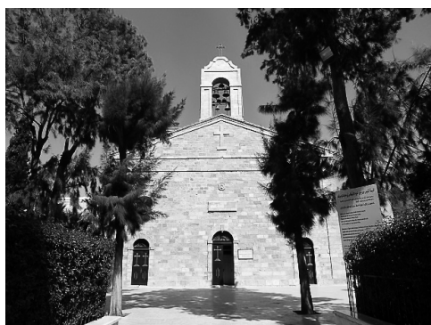
写真2 聖ジョージ・ギリシア正教会外観
