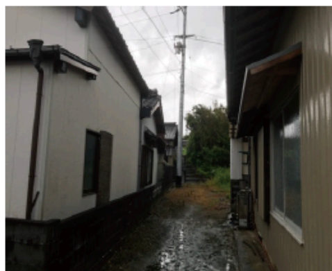
黒潮町のI地区（津波避難路となっている道路沿いの住宅はすべて耐震改修済み）
