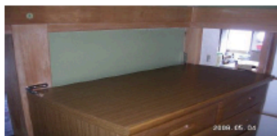
大きな家具は柱に直接固定
