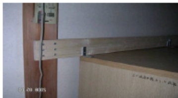
柱間に板を渡して固定
