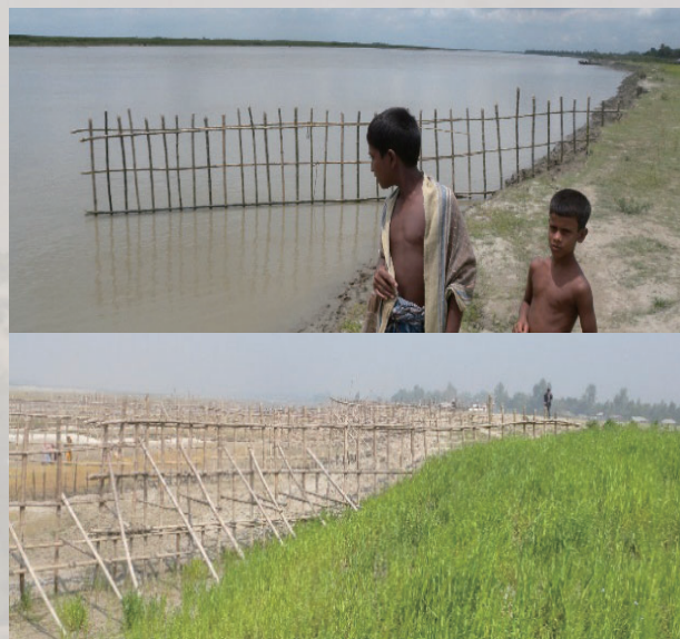
図5 上の写真：洪水前にバンダルを設置（下部の透過部分（竹製）のみ完成。上部の不透過のフェンス部分は未設置）。下の写真：洪水発生1年後に形成された河岸付近の土砂堆積部分が麦畑に変身。再生された土地が自分の土地であることを作付けしてアピール。
