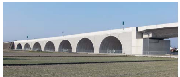
写真1 多ユニットアーチカルバート盛土（写真の現場は盛土材として軽量盛土が使用されているため通常の盛土材を用いた時よりユニット間隔が狭くなっている）
