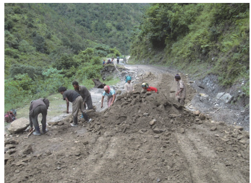
写真6 土砂崩後に道路整備をしている様子 （2009.07.30 撮影）
