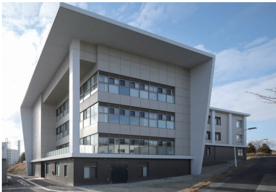
第二研究棟 外観 北東面
