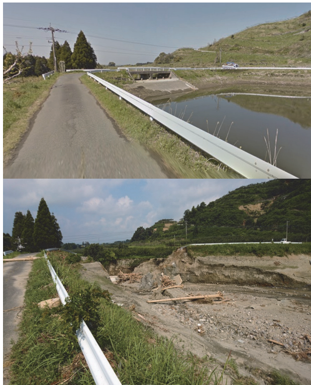
図3-2 決壊した山の手ため池(奈良ヶ谷川) 上:決壊前(Google Earthより)、下:決壊後
