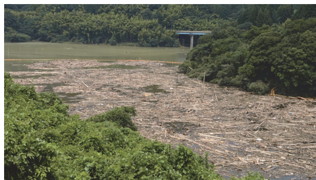
図3-4 寺内ダムの湖面に捕捉された大量の流木
