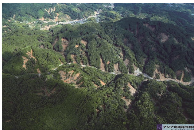
図2-1 片岩地域の崩壊発生状況（奈良ヶ谷川）。片岩には片理面が発達しており、それに沿って滑った崩壊は深く、そうでない場合には、浅い場合が多い（撮影 アジア航測株式会社）
