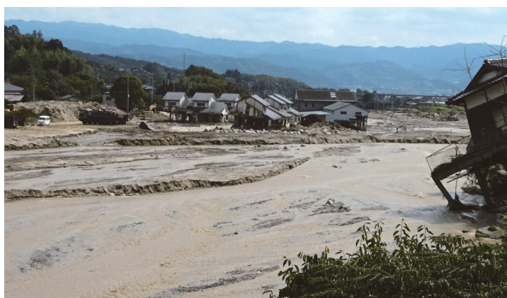
図3-1 氾濫した赤谷川
