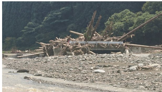
図3-3 流木で閉塞した橋梁(寺内ダム上流・黒川)
