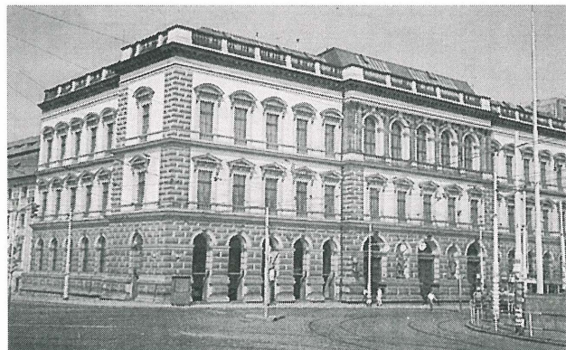
CTU 機械工学部の正面玄関と教室
