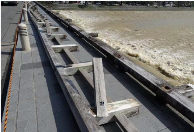
図 2.3.1.6 渡月橋の欄干の倒壊 (京都大学八木教授撮影) (左) と学校門扉の転倒 (大阪府貝塚市, 日本建築総合試験所 前田氏撮影) (右)
