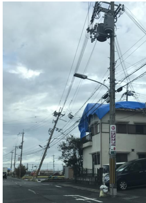
図 2.3.2.2 1 本の電柱のみが基部で破損した例 (大阪府泉南市田尻町 2018/9/7 著者撮影)
