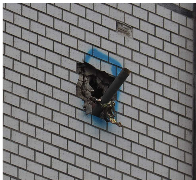
写真 2.2.8.4 外壁に残った単管パイプと緊結金具 Photo 2.2.8.4 Tube pipe and clamp remaining on outer wall
