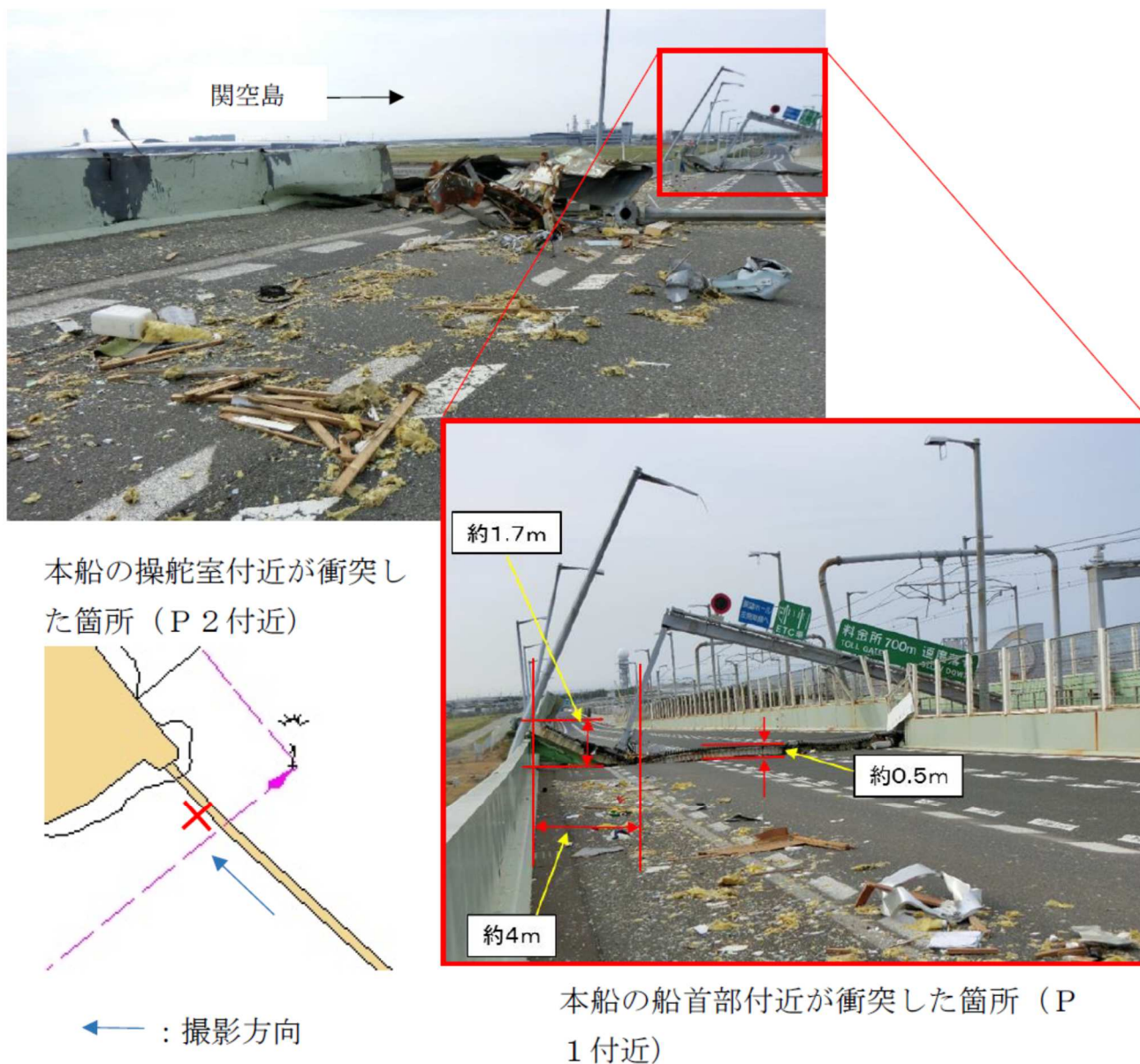
図 2.2.7.9 関西国際空港連絡橋上の損傷状況 1)
