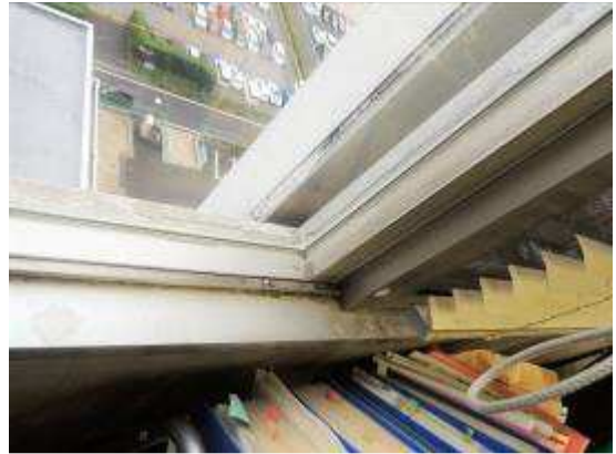
写真 2.2.1.17 庁舎Dの10階で破損した窓ガラスのサッシ (復旧済み)
