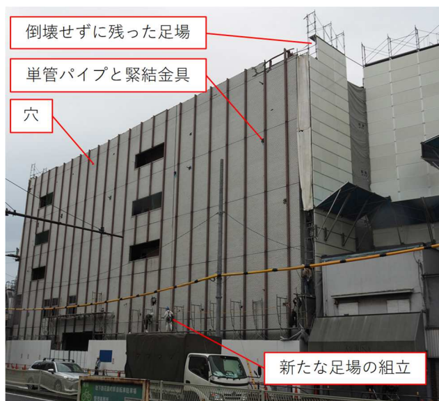
写真 2.2.8.3 大阪市南部の足場倒壊現場 Photo 2.2.8.3 Scaffold's collapse site in south of Osaka
