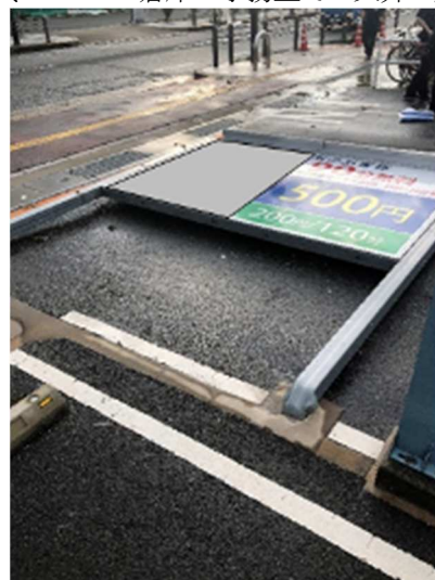
写真 2.2.1.44 看板脚部の折損 (当該店舗提供)
