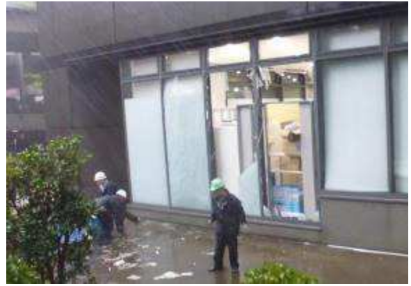
写真 2.2.1.2 1階東面窓ガラスの破損 (当該庁舎提供)
