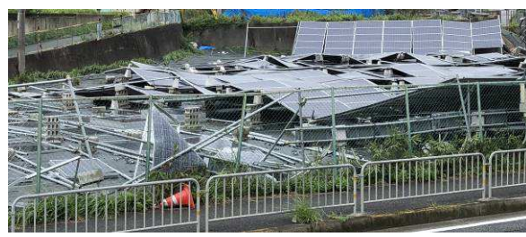
工作物①太陽光パネルの散乱
