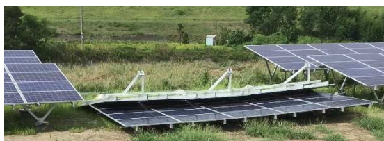
(a) パネルと支持部材の飛散 (図 2.1.2.2, 地点 G)
