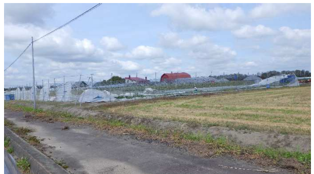
写真 2.1.5.8 プラスチックハウスの倒壊（長沼町）
