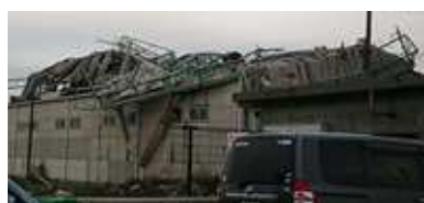
住宅外③車止め大屋根のめくれた様子(右イラスト)
