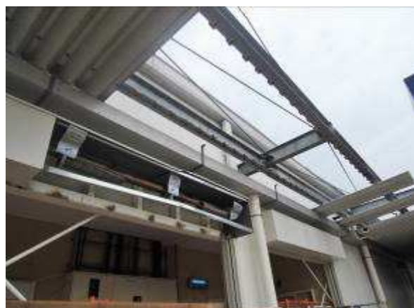
写真 2.2.1.43 庇の屋根材の脱落とシャッターの損傷
