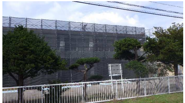
写真 2.1.5.4 屋根の応急修理のための足場（恵庭市）
