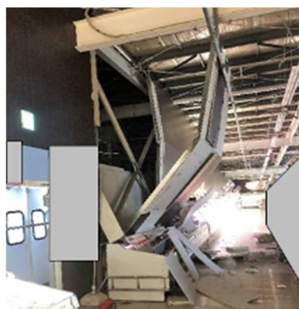
写真 2.2.1.40 店舗南西側の間仕切 (当該店舗提供)
