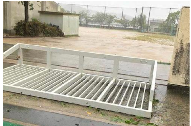
図 2.3.1.6 渡月橋の欄干の倒壊 (京都大学八木教授撮影) (左) と学校門扉の転倒 (大阪府貝塚市, 日本建築総合試験所 前田氏撮影) (右)
