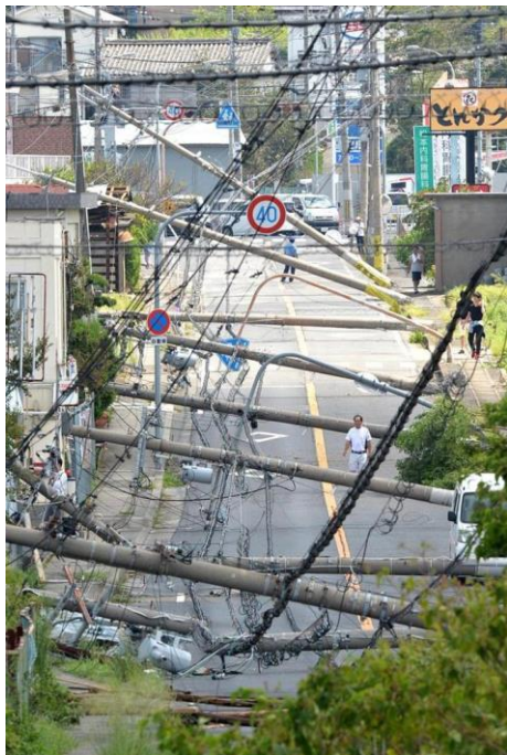
図 2.3.2.1 複数の電柱が倒壊した被害例 2) (大阪府泉南市新家 産経ニュース 2018/9/5 15:55)
