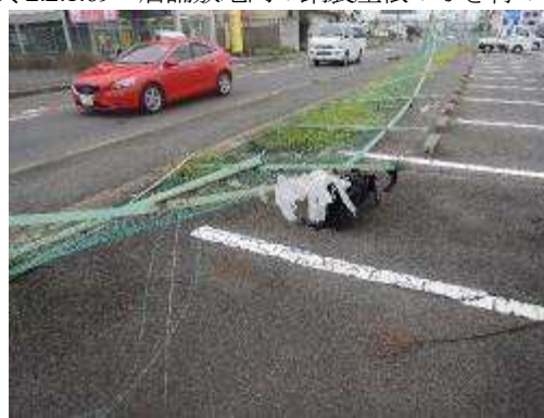
写真 2.2.1.71 フェンスの著しい変形
