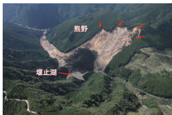
写真3 和歌山県田辺市熊野地区の地すべりと堰止湖（道窪幸雄 2011.9.10 撮影）
