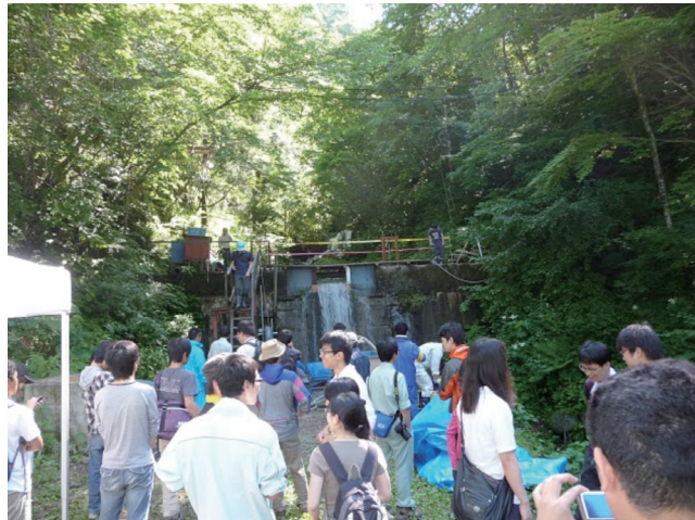
土砂吸引工法による土砂排砂実験
