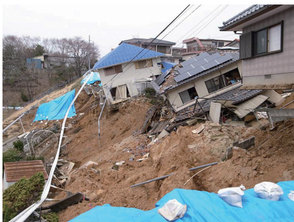
写真1 谷埋め盛土地すべり末端部の崩壊（福島市あさひ台）
