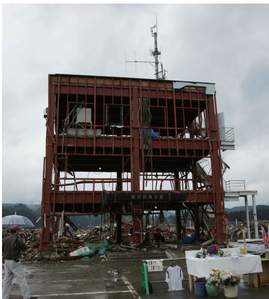
写真1 南三陸町の災害対策棟
