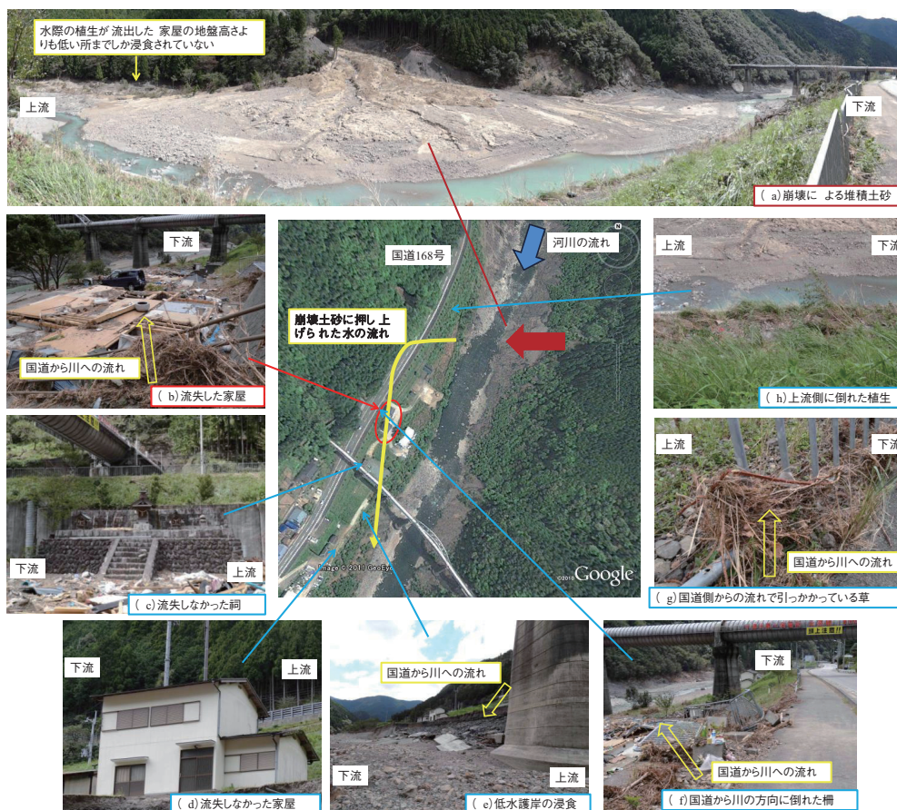
写真 1 十津川村野尻における被災状況
