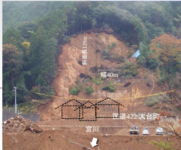
図8 三重県宮川村滝谷地区で発生した斜面崩壊
