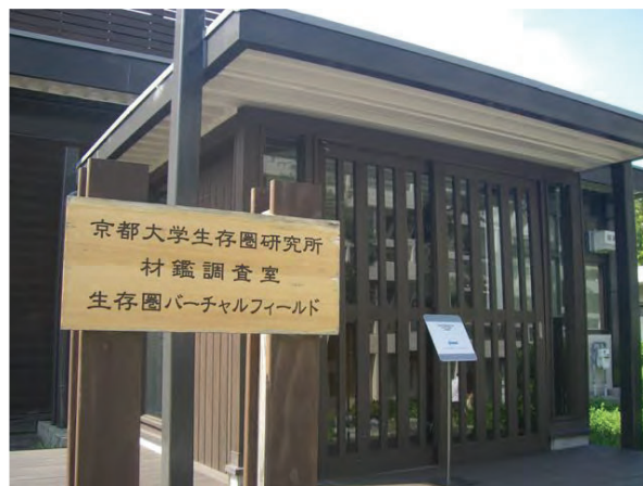
材鑑調査室外観
