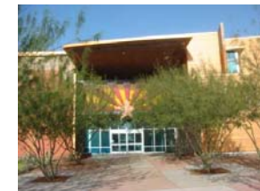
文書館棟(2008年竣工)
