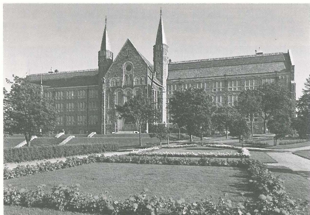
ノルウェー工科大学本館
