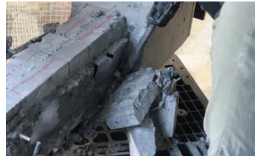
図-15 鋼板位置でのはつり作業の様子
