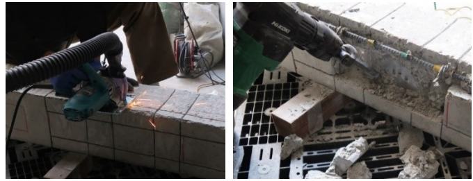
(a) 切れ込みを入れる様子 (b) チッパーではつる様子 図-9 取替実験の様子
