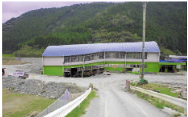
写真2 宗呂川の氾濫で床が落ちた土佐清水市下川口中学校体育館
