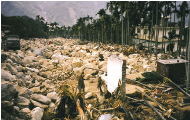
写真2 郡坑村の土砂災害状況
