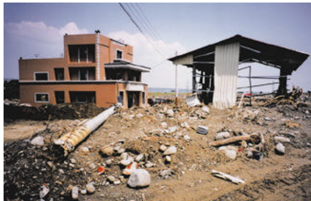
写真1 木屐寮の洪水災害状況
