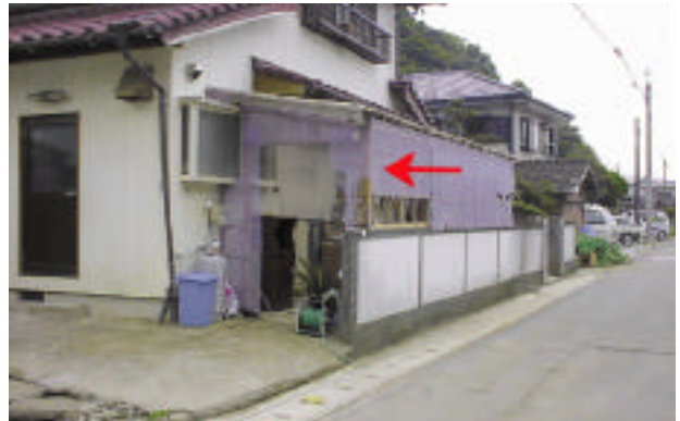
写真3 大月町周防形地区 (矢印位置に浸水痕跡。道路からの高さ約2m。)
