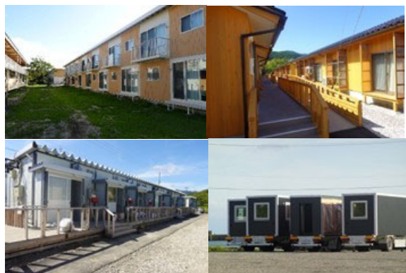
2024 年能登半島地震の応急仮設住宅
