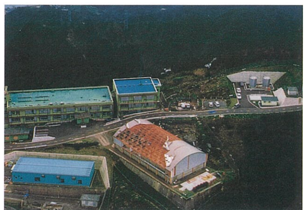
写真1 屋根がとばされた下甕島の体育館
