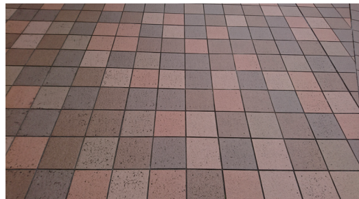
図 5-2 同志社女子大学京田辺校地の石畳（拡大） ※タイルとタイルの間隔が狭く溝の凹凸もほとんどない
