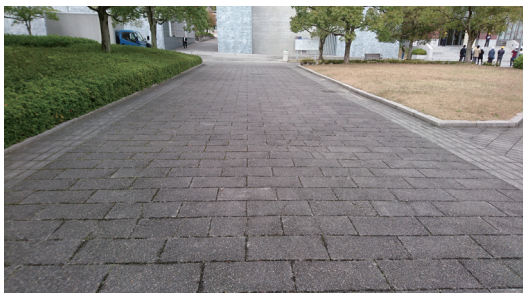
図 4-1 同志社大学京田辺校地の石畳① ※表面に凹凸のある石畳
