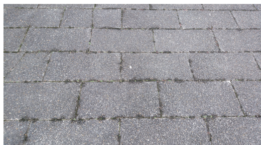
図 4-2 同志社大学京田辺校地の石畳①（拡大） ※表面のみならず全体にうねったような凹凸がある
