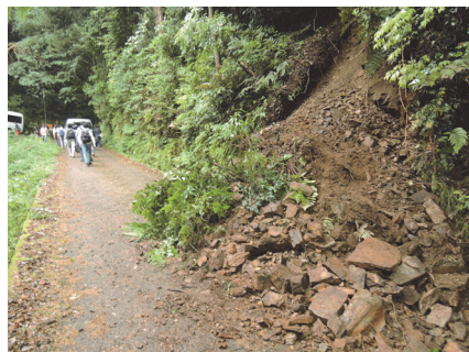
pic.1 土砂崩れの様子
