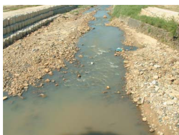
野田川中流。左岸はサンドバック、川底は土石流が運んだ礫と砂。これから重機が浚う。
