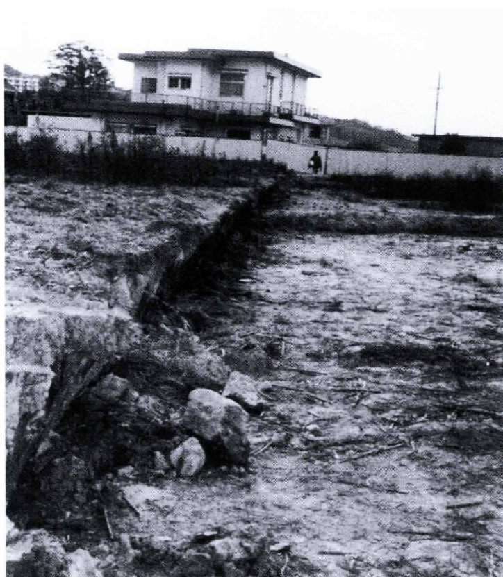
図1 野島断層（写真提供 京都大学防災研究所） 現在、この上に断層記念館が建てられ、断層の風化を防ぐ処置がなされている
