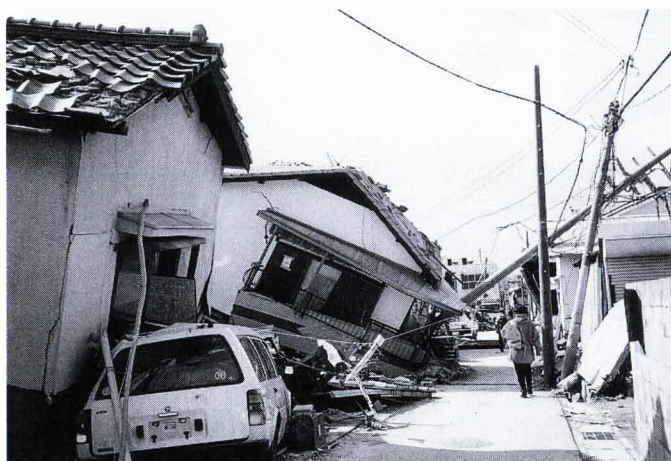
図2.3 兵庫県南部地震で倒壊した家屋 (上下とも兵庫県芦屋市内)
