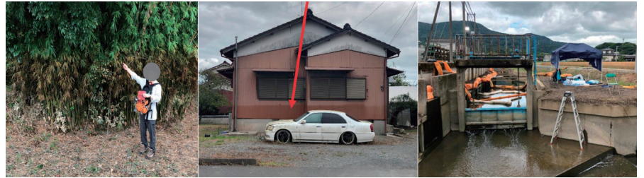
図1 佐賀県大町町の鉄工所において、植生への油流出被害(左)、目視できる浸水線(中央)、流出油を含んだプールの使用状況(右)を示す写真。2019年8月佐賀県大町町。
