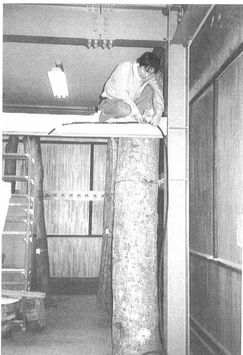
写真-1 ガス注入用パイプ取付け
