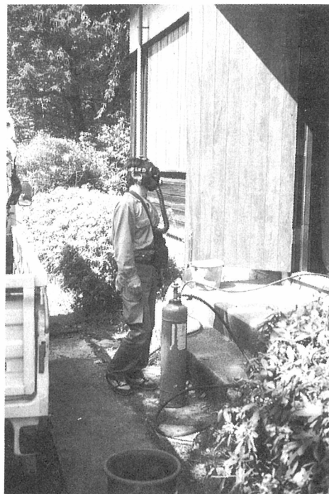
写真-4 ガス注入
