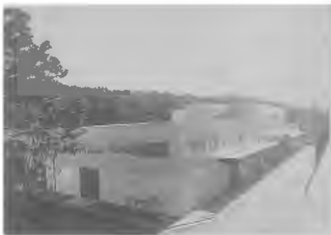
写真9-1 機械系教室実験研究棟
