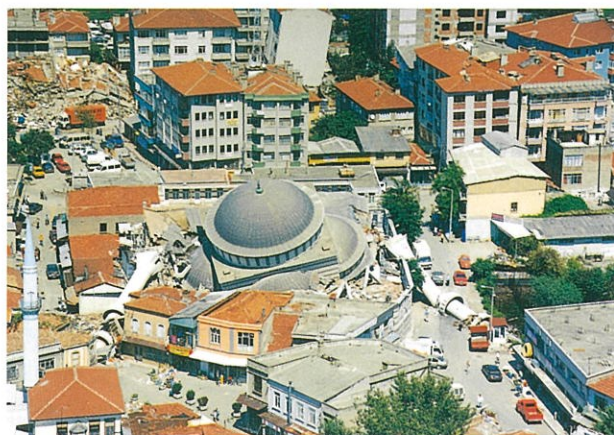
アダバザルの倒壊したモスク（8月31日撮影）
