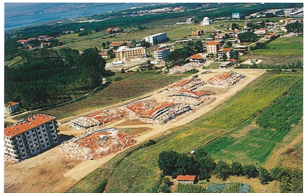
イズミット市での被害の例。このアパート群の建っていた敷地内を断層が走っている (8月31日撮影)
