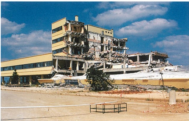
コジャエリ (イズミット) 大学の造営中の新キャンパス内の建物の被害 (7月17日撮影)
