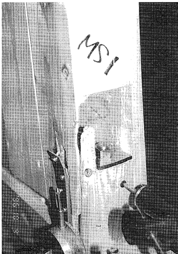
写真7 MS-1の破壊形態。土台-柱固定用引きボルトの余長が足りなかったため、せん断破壊を起こした。余長は12cmであった。(A78068/#5)
