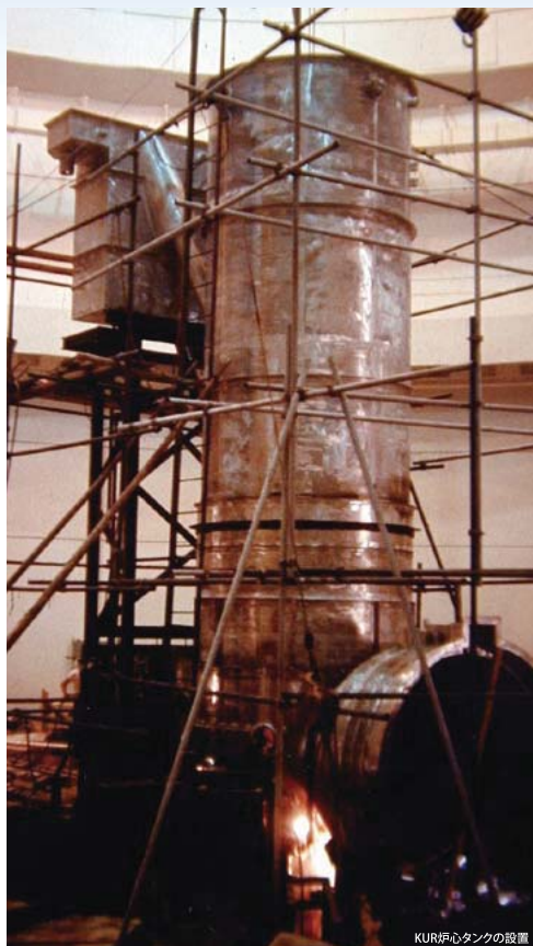
KUR炉心タンクの設置
