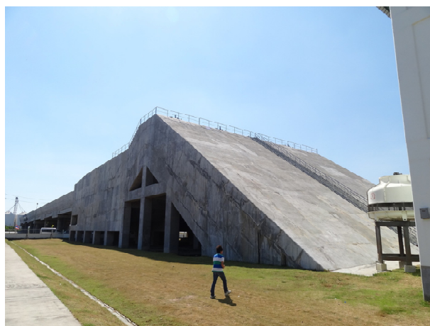
(b) 高架型の排水路
