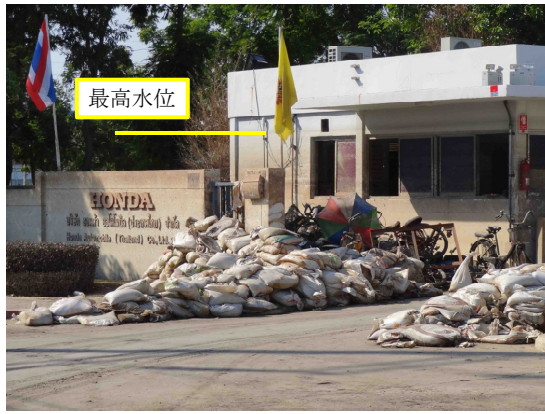
(a) ホンダ自動車の工場
