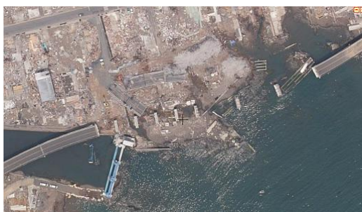
写真 26 歌津大橋の津波による流出 30)
