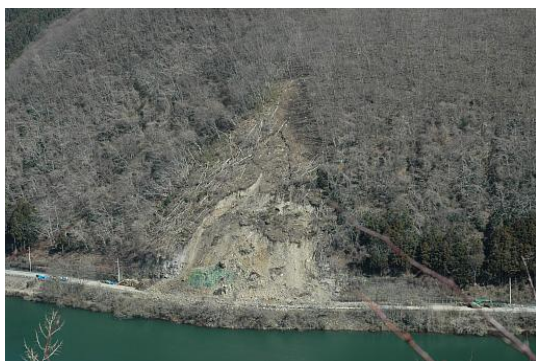
写真 23 自然斜面崩壊（国道45号，石巻市合戦田谷）
