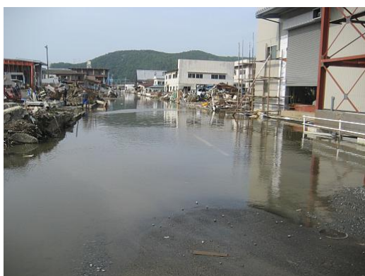
写真 31 旧北上川左岸河口部の地盤沈降と浸水状況（石巻市川口町二丁目付近）
