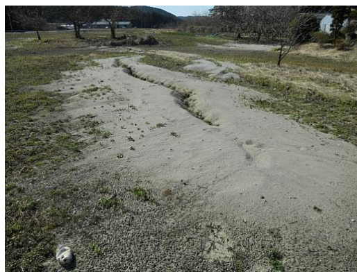
写真 28 堤内地の液状化による噴砂とクラック（石巻市河南町北和淵、西八反崎）
