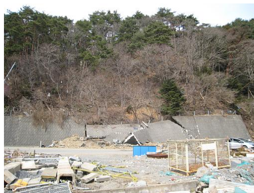
写真 19 県道238号沿いの斜面崩壊（石巻市雄勝町雄勝）
