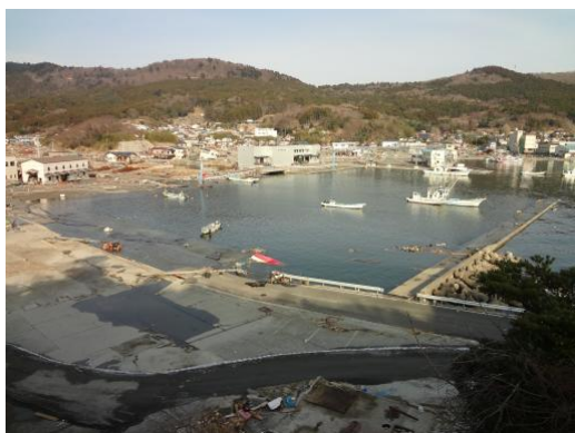
写真 30 鮎川港周辺の地盤沈降（石巻市鮎川浜，県道2号から望む）
